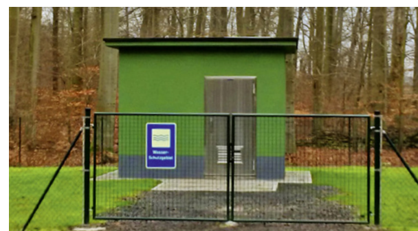
Seit September 2018 in Betrieb: der neue Tiefbrunnen.
