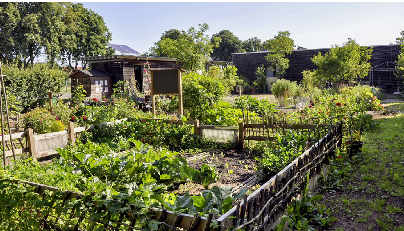
Mit der innovativen Konfiguration aus Brennstoffzelle, PV-Modulen auf dem Geräteschuppen und Energiespeicher können die Stadtwerke die CO 2 -Emissionen des Umweltzentrums Hanau um bis zu 50 Prozent senken.
